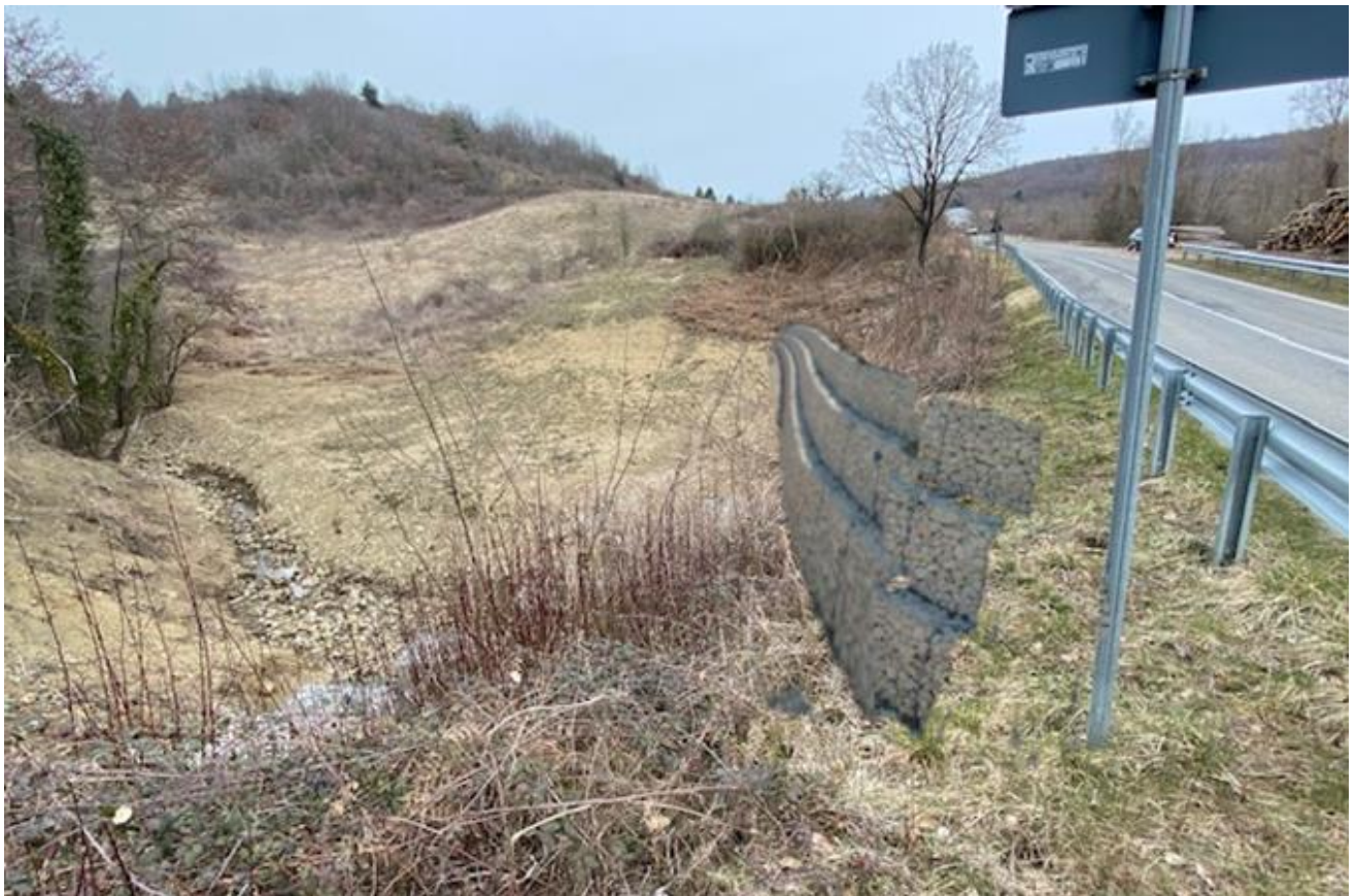
Foto 6 simulata: l'immagine mostra il muro in gabbioni di pietra utilizzato come paramento esterno sul fianco dell'argine, all'interno del quale corre il termodotto , a fianco della strada provinciale n°160 .
